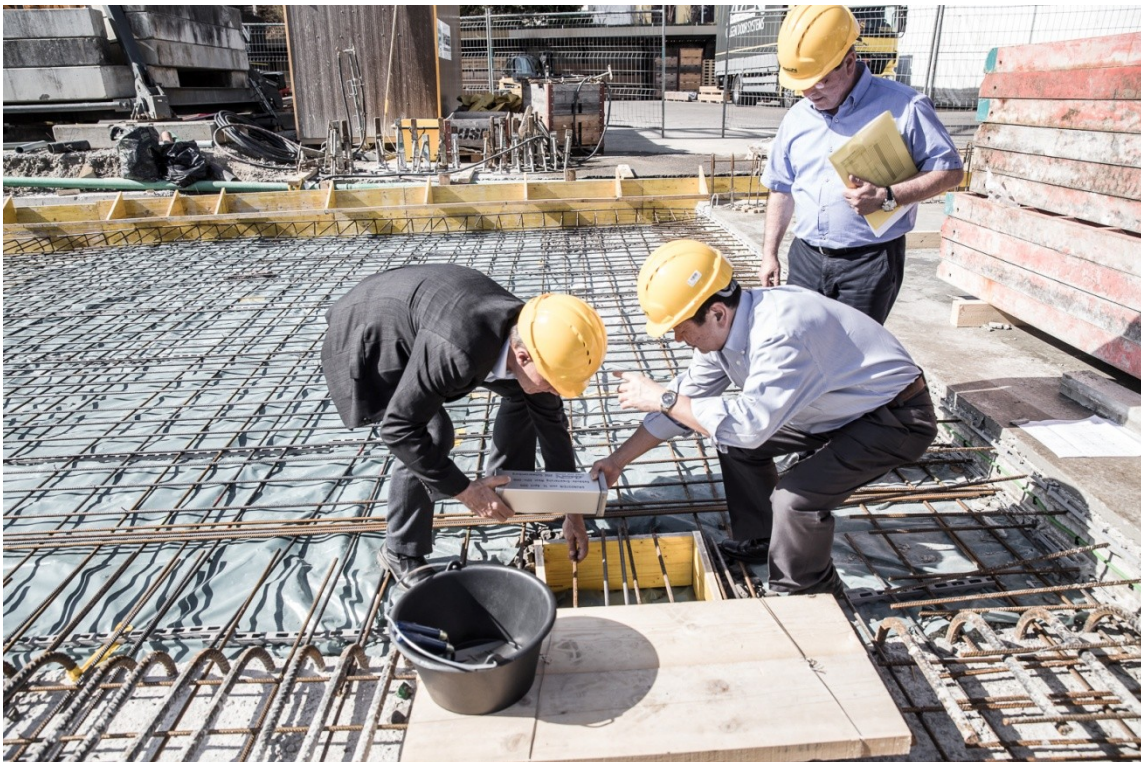
La primera piedra del nuevo edificio en Schwarzenburg es cementada.
